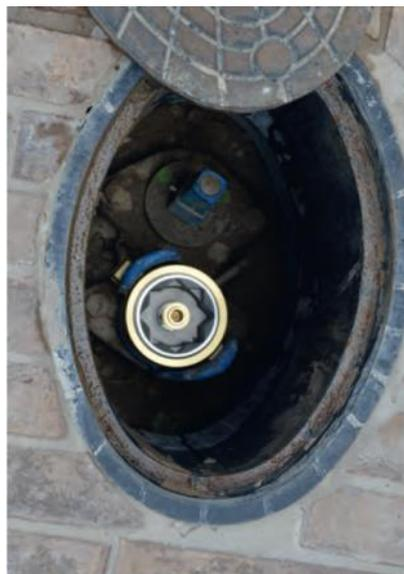
Hydrantenverschluss mit Schnellverschluss NW 7.2 am Hydranten DN 80
